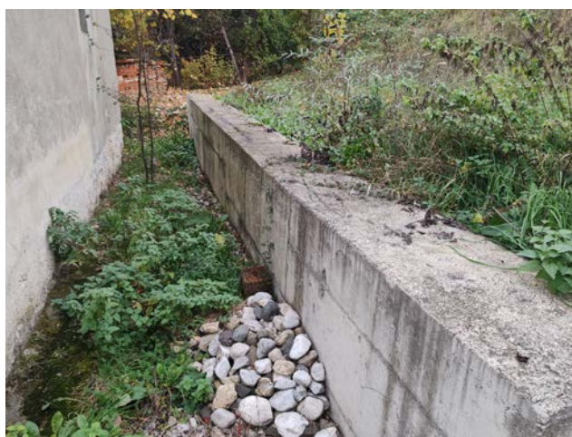
Слика 16. Потпорни зид на шиповима на к.п. 11587 К.о. Ваљево
