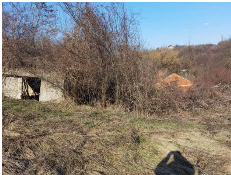
Слика 12. Порušени објекти услед клизишта активираниг насипањем на одсеку тј. старом чеоном ожилъку испод северног крака Ул. Иве Андрића
