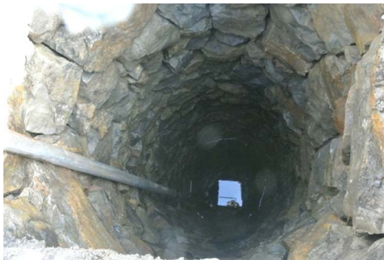
Слика 7. Изглед бунара на к.п.11579, где нема видљивих трагова деформација
