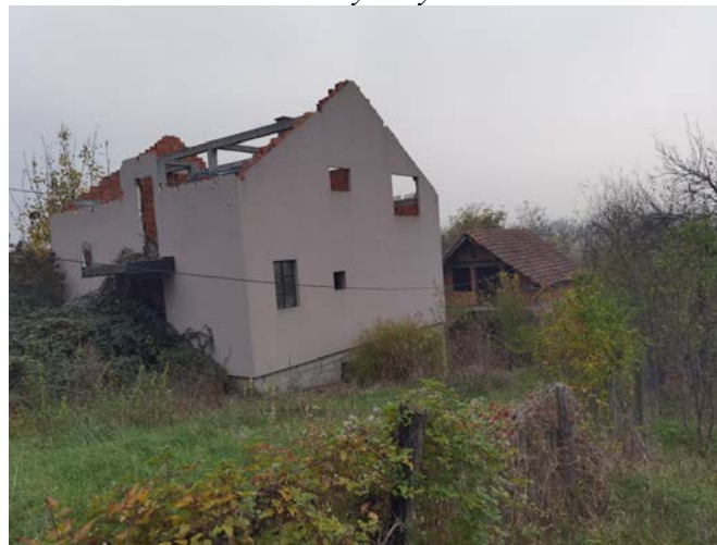
Слика 11. Оштећени објекти услед активног клижења у делу испод Ул. Јакова Ненадовића
